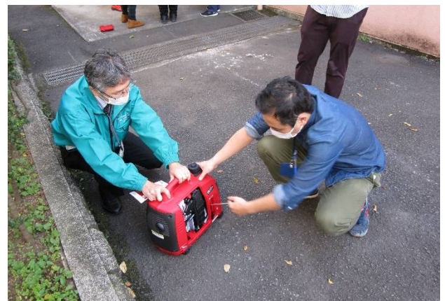
【 小型自家発電装置を起動する様子 】
